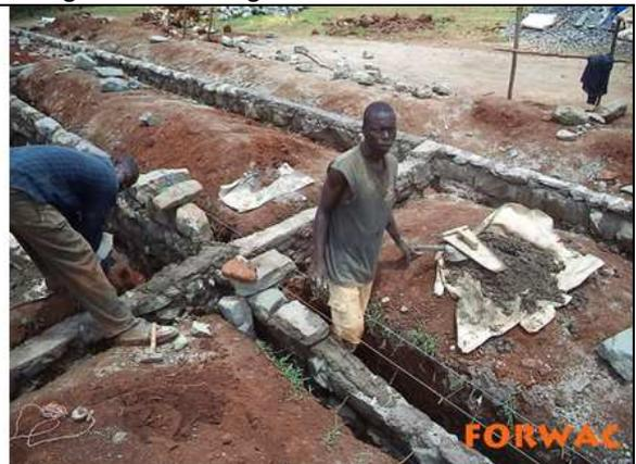
Ausschachten für das Fundament und Stabilisierung der Wände.
