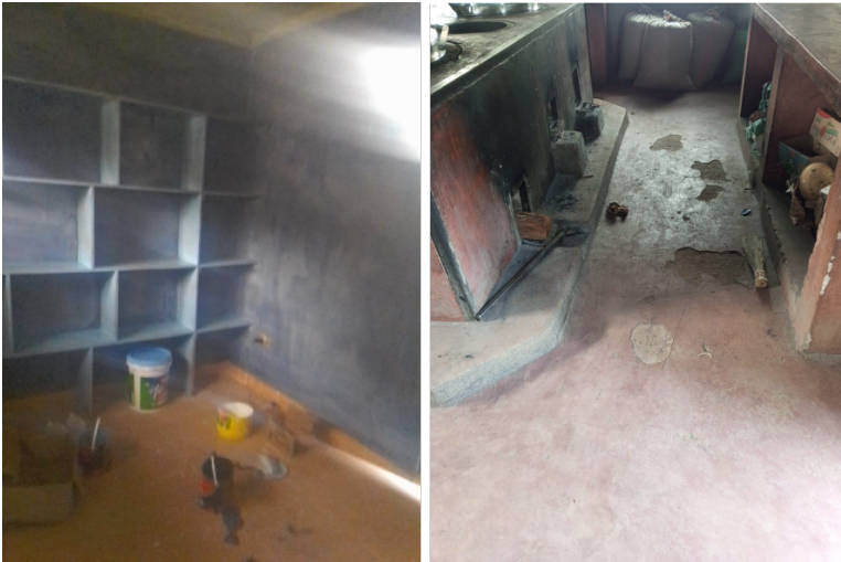
Abbildung 10: Boden- und Malerarbeiten im FORWAC-Gebäudekomplex. ©FORWAC e.V.
